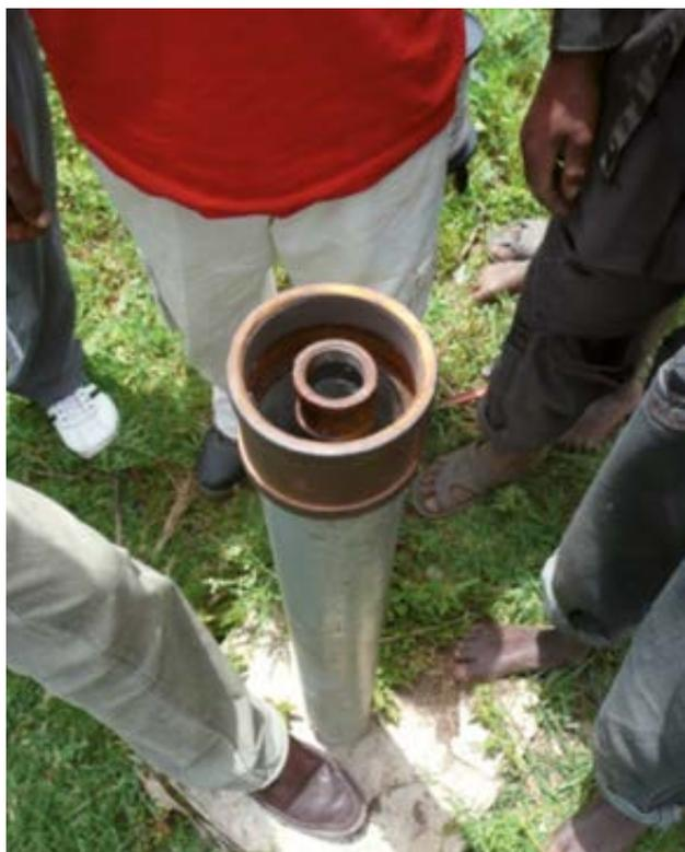
*Figure 5.3 Un exemple d'ouvrage de suivi : un tubage crépiné de 1'' ou 2'' avec un tubage supérieur de 3 ou 4'' qui protège l'ouvrage des inondations et permet de visser un bouchon de protection approprié. Les piézomètres d'observation de 1'' sont faits pour les mesures de niveau de l'eau uniquement (avec une sonde d'eau ou un capteur). Ceux de 2'' permettent également l'échantillonnage de l'eau avec un tube de prélèvement.*
